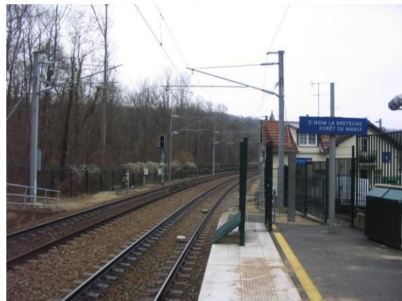
Figure 21 : Photographie des quais de la GCO – Saint-Nom-la-Bretèche
